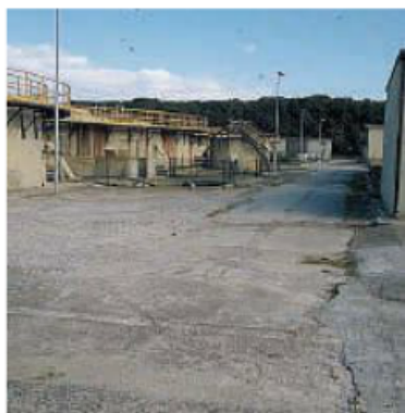
Depuratore consortile di Corvo. Manutenzione ad andamento lento
