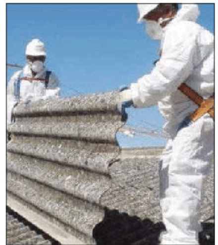
Lo rimozione di lastre eternit dai tetti
