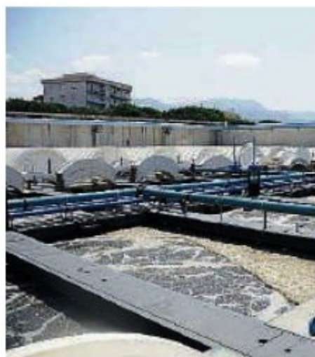
Da svuotare. Alcune vasche del depuratore di Ravagnese
