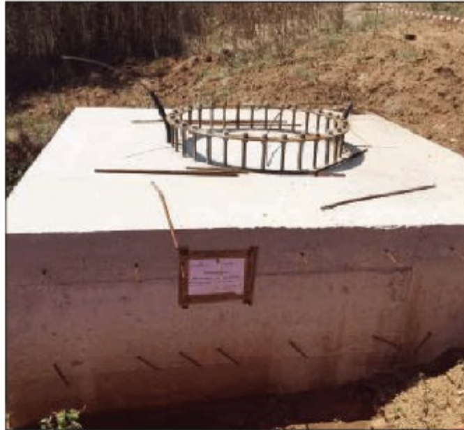
Una delle strutture in cemento sequestrate
