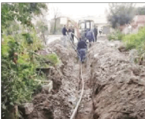
Gli operai al lavoro sulla rottura a Nocera Terinese
