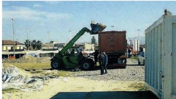
Canalone dei veleni. La rimozione della sabbia inquinata
