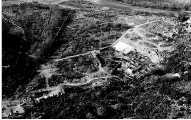
L'impianto visto dall'alto
