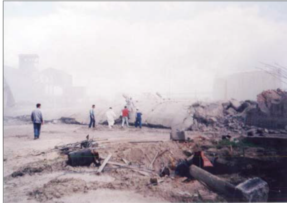
La demolizione della storica ciminiera dell'ex Montedison di Crotona
