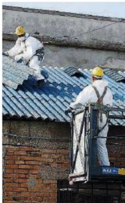
Bonifica. Un intervento su un tetto
