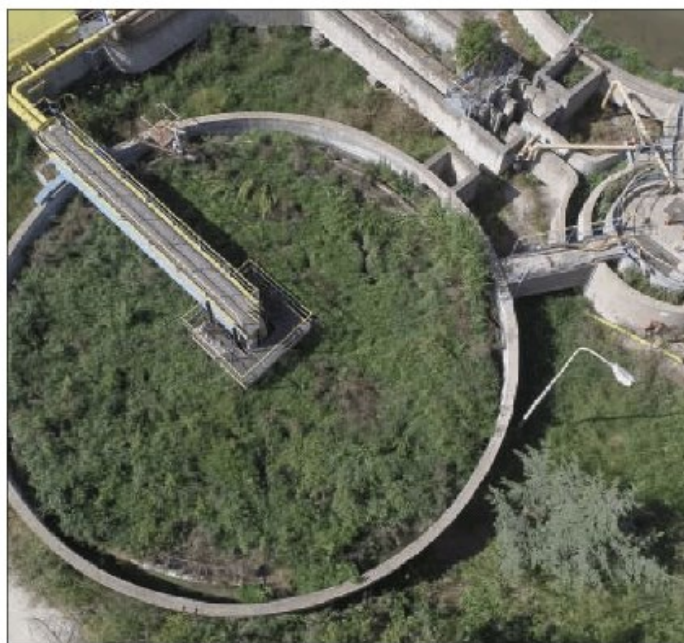
Il depuratore comunale di Crotona
