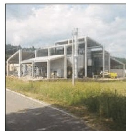
La centrale in costruzione
