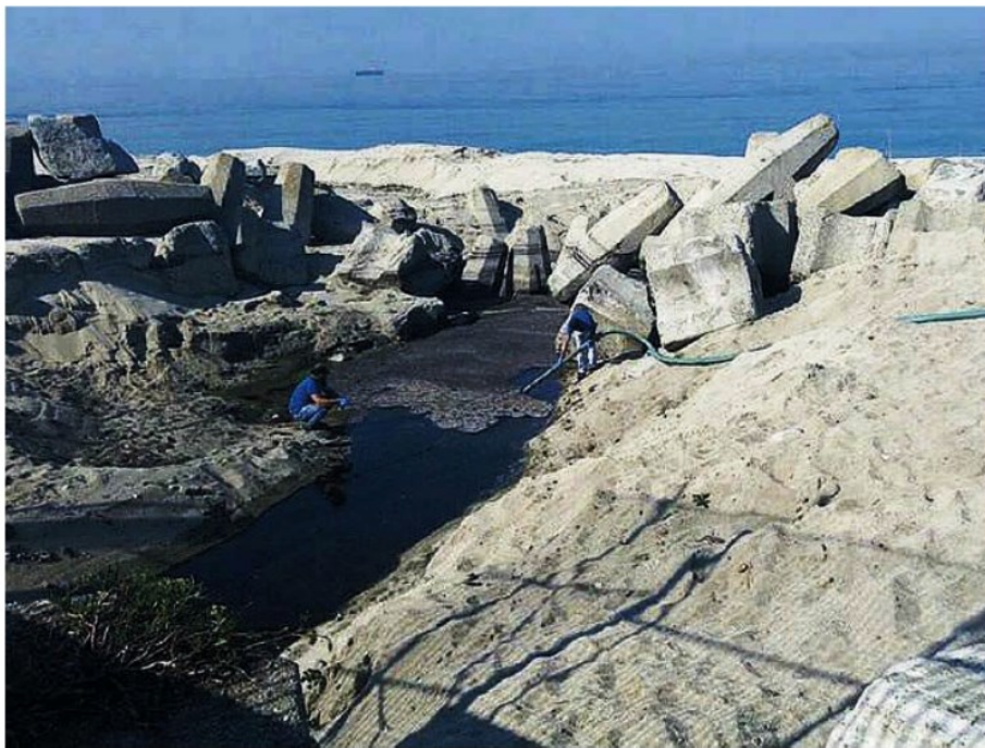
Canalone dei veleni. L'intervento per l'aspirazione dei liquami alla foce del canale di scolo
