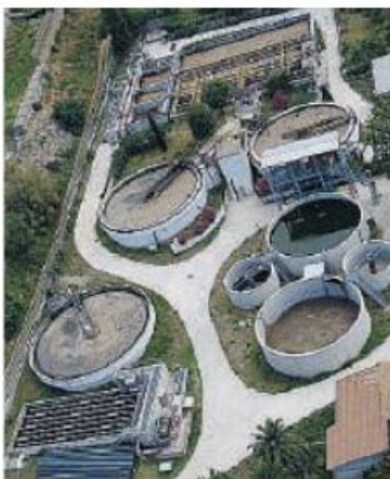
L'impianto di depurazione.
