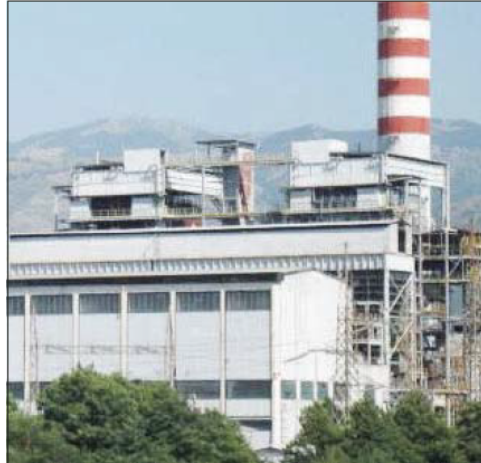
La centrale del Mercure
