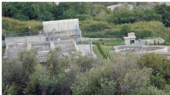
L'impianto sott'accusa. Il depuratore consortile di località Argani
