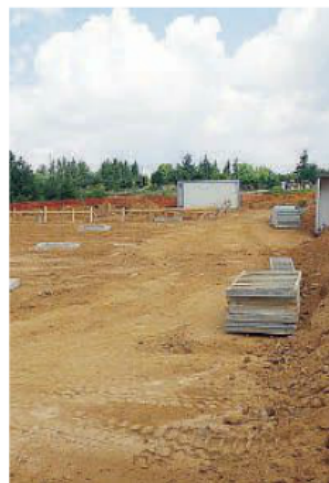
Il cantiere. L'area su cui dovrebbero sorgere le centrali
