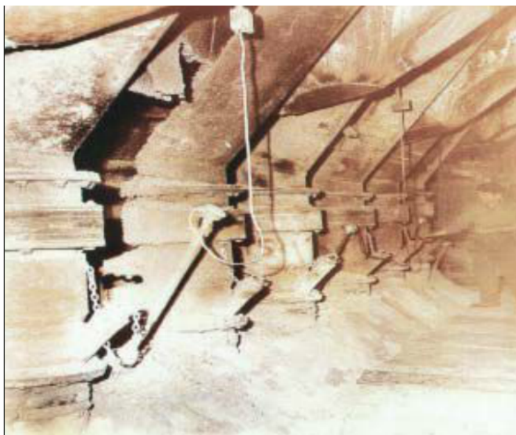
Il reparto forno fosforo dell'ex Montedison
