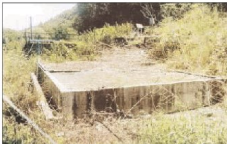
In alto: l'impianto di Lattarico centro, a destra: il depuratore di Piretto
