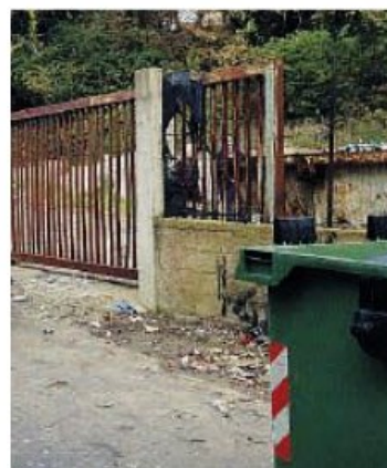
Isola ecologica mai decollata. L'impianto di via della Resistenza
