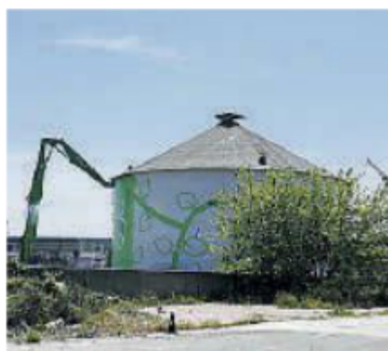
L'avvio della demolizione del silos
