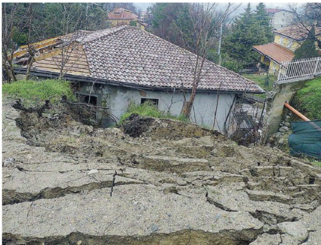
Un territorio a rischio dissesto. Nell'immagine del 2 febbraio scorso la palazzina sprofondata nel terreno franato a Foresta
