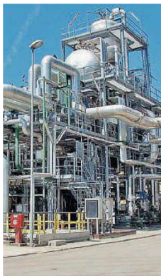
Una centrale a biomasse. L'impianto sta provocando una sfilza di polemiche
