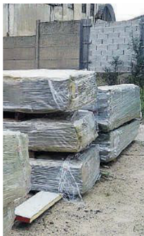
Lastre di amianto accatastate
