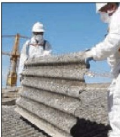
Un tetto in cemento-amianto
