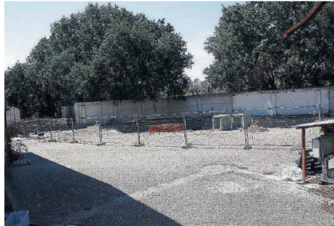
I lavori in via del Progresso. Uno degli impianti che sta realizzando la società Vitale Sud
