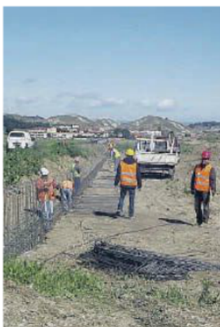
L'ex discarica. Sarà sorvegliata fino alla messa in sicurezza
