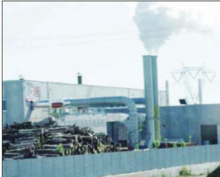
Una centrale a Biomasse
