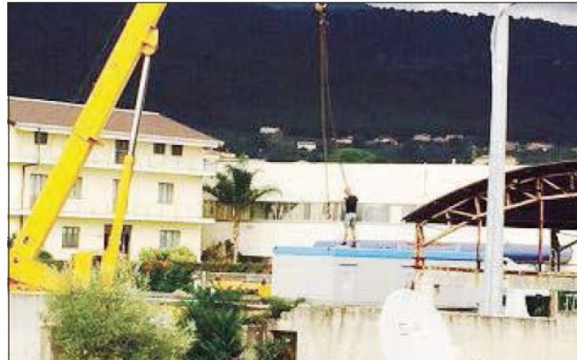
I lavori di installazione
