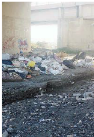
Degrado. Questa la situazione nell'area del torrente Molaro II
