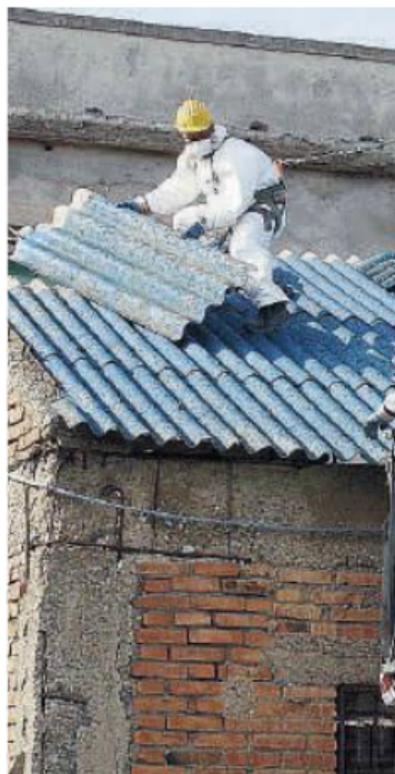
Rimozione di un tetto in eternit. Ora c'è l'ordinanza del sindaco
