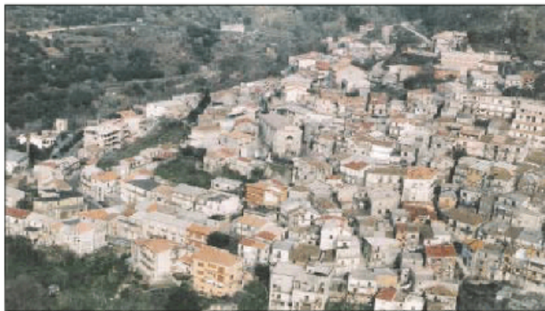
Una veduta dall'alto di San Nicola da Crissa e una centrale a biomassa
