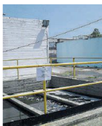
Depurazione nel mirino. L'impianto di contrada Sant'Angelo
