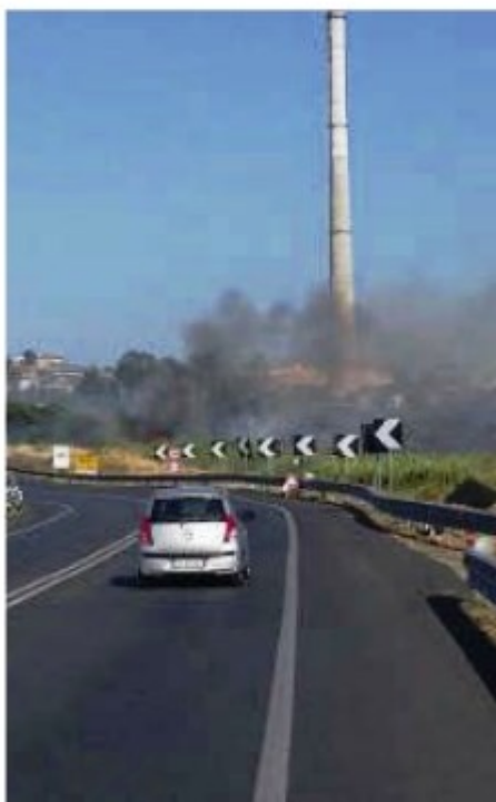
La ciminiera. L'incendio alla vecchia fabbrica visto dalla Statale 106
