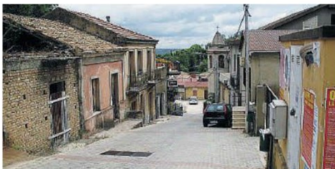
Solano Inferiore. L'abitato della frazione collinare di Bagnara
