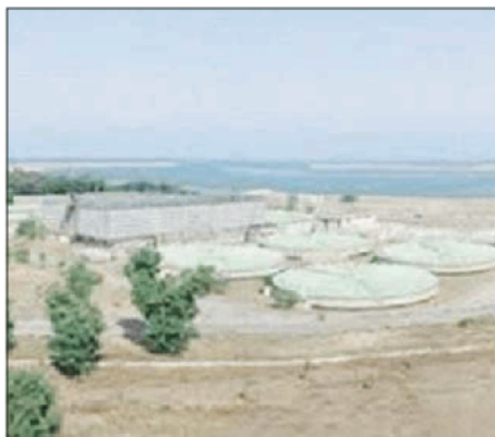
L'impianto di depurazione della Iam a Gioia Tauro
