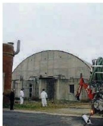
Azienda chimica. Il vecchio capannone della Bp di Siderno
