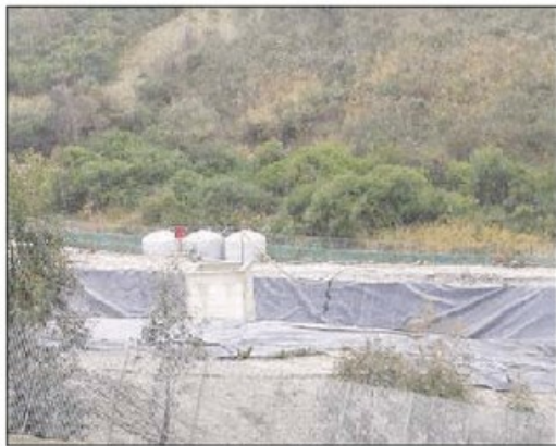
Una veduta della discarica di località Pipino
