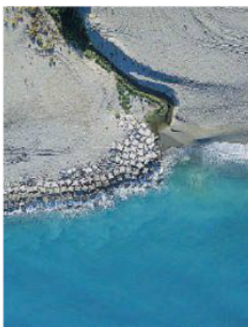
La foto aerea. Catturata dal drone
