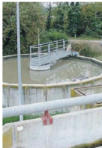
Una vasca del depuratore. Investimenti sull'impianto
