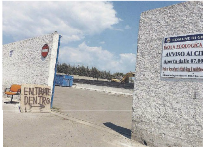
Isola ecologica. L'impianto in funzione sulla Strada provinciale 1 resta aperto
