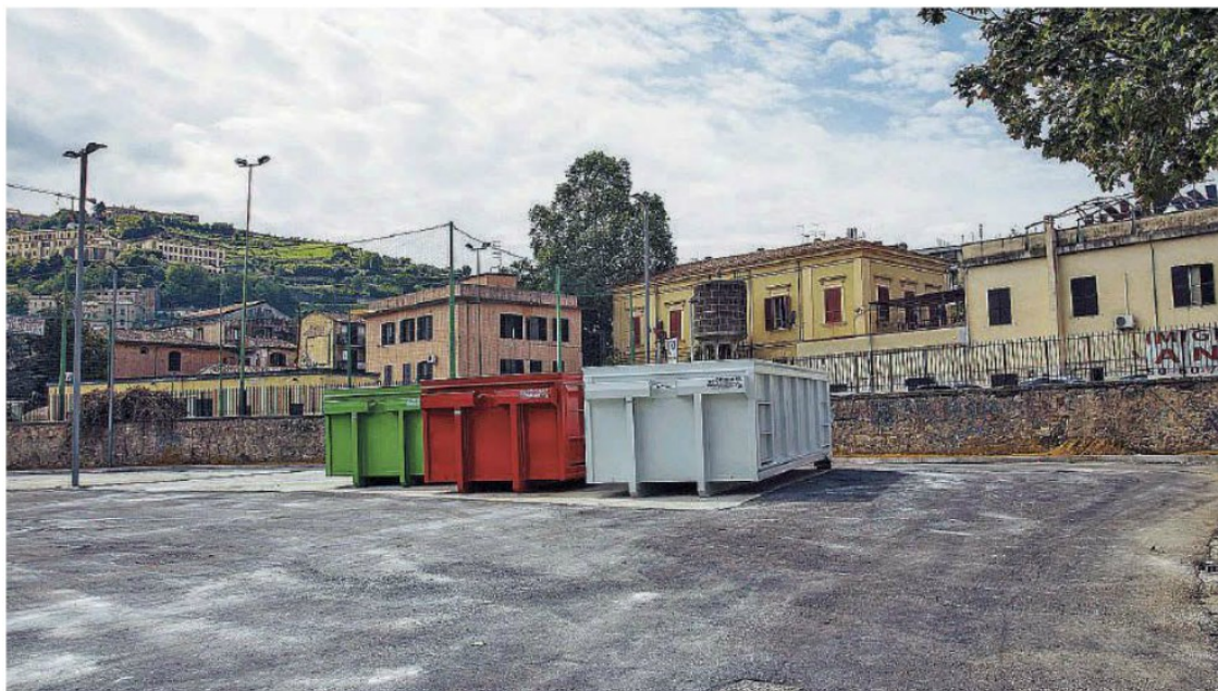
Primi cassoni nell'area dell'isola ecologica. I contenitori in tutto saranno cinque, di colore diverso, in base al rifiuto da conferire FOTO ARENA
