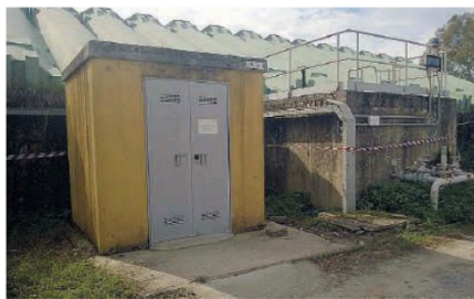
Depuratore di Gioia Tauro. Gli impianti posti sotto sequestro
