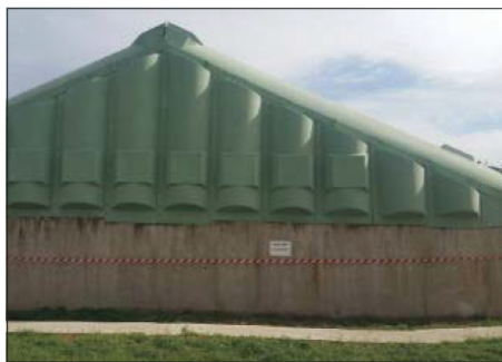
La vasca del depuratore sotto sequestro coperta da un telone
