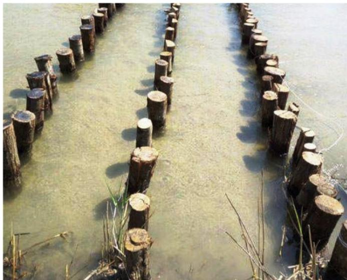
Il progetto. La barriera in legno finalizzata ad arginare la corsa dei detriti lungo il fiume Mesima
